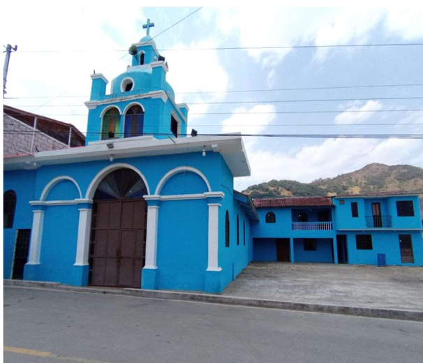
Figura 73. Iglesia de Cañaribamba Elaboración: Equipo Consultor
