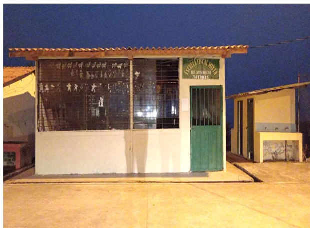
Figura 100. Escuela y Baños de la comunidad de Totoras Elaboración: Equipo Consultor
