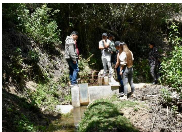
Figura 155. Captación y canales de riego Fuente: GAD parroquial de Cañaribamba Elaboración: Equipo Consultor
