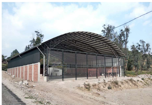
Figura 75. Cancha con cubierta Cañaribamba Elaboración: Equipo Consultor
