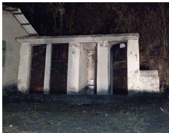
Figura 95. Baños públicos de la comunidad de Chalcalo Elaboración: Equipo Consultor
