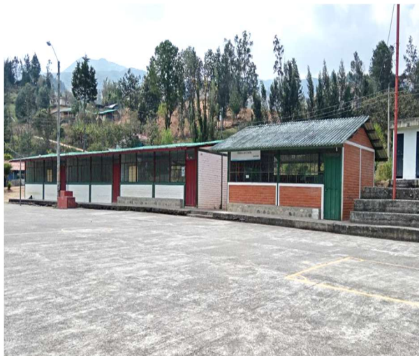
Figura 84. Escuela de la comunidad de Salinas Elaboración: Equipo Consultor
