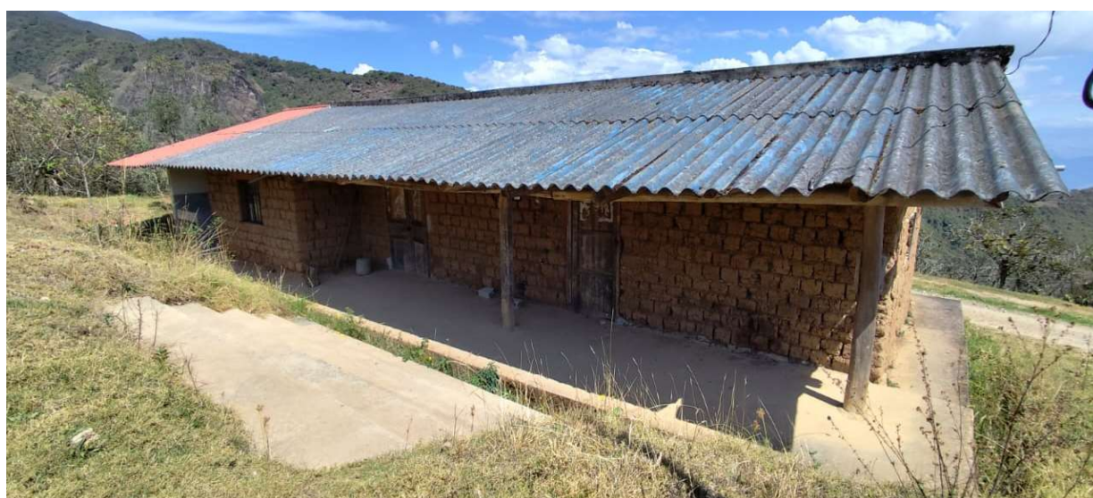
Figura 107. Casa comunal de la comunidad Paccha Elaboración: Equipo Consultor
